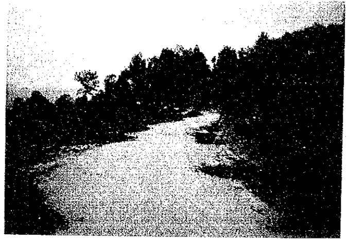
側溝および法面整備現場 24号線（ツブongo付近）
