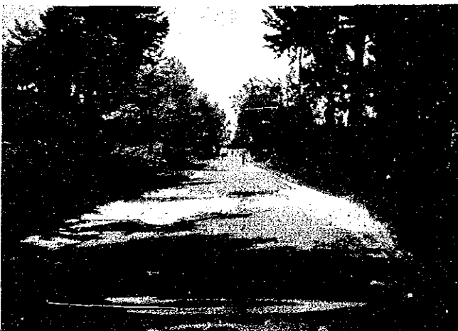
橋梁補修が必要な道路 8号線 (ギショマ付近)
