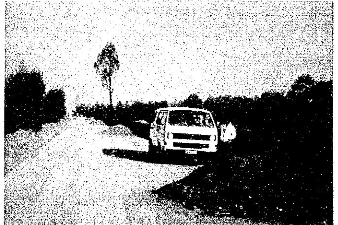
道路拡幅、路面修正現場 41号線（ガコ付近）
