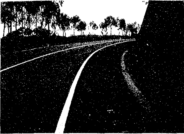
整備された道路 3号線 (キレンゲ付近)
