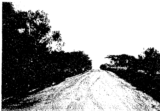
拡幅、路面整正された道路 14号線 (カンゼンゼ付近)
