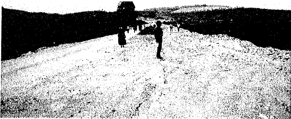
超軟弱地盤地域のため大規模な維持管理が必要な道路 41号線（ブソロ付近）
