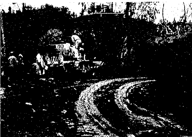
リッパー付ブルドーザーによる道路拡幅現場 38号線（ギスマ付近）
