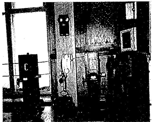
写真-21 相手駅から受ける閉塞装置(ザミンウッド駅)
