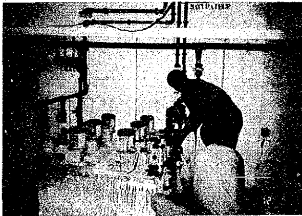
ヤンタラ浄水場
