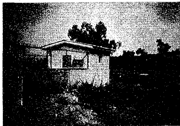
ヤンタラ浄水場 グデルより自然高下 で送られて来る原水 のステーション
