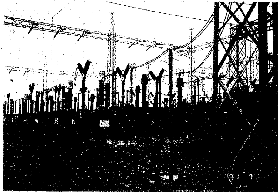
La Trinidad Substation
