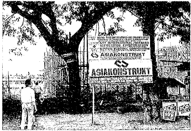
ナガ市内 NTP1-1プロジェクトで 建設中の電話局
