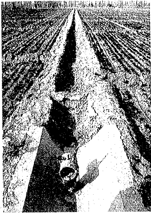
ポーター灌漑用の圃場内水路とパイプライン吐水工
