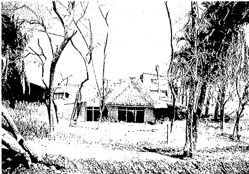
▲ 同 上 泥流に埋もれた家屋
