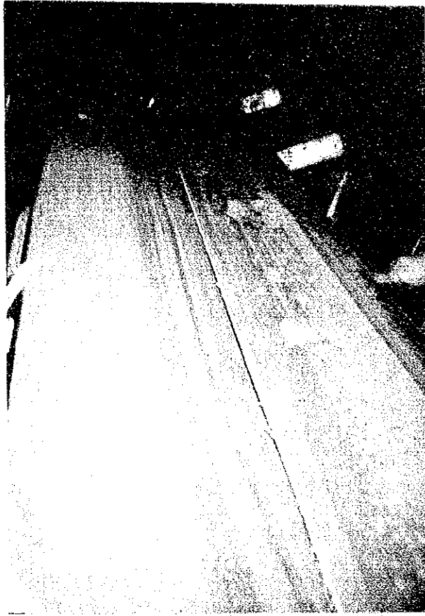
図4-2-19 コンベアーベルト損傷現場状況写真
