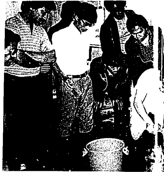
10月24日、コンクリート試験 ▲
