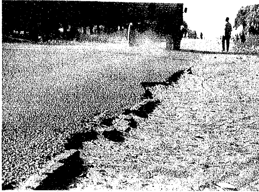
路肩段差でトラブルに巻き込まれる隊員もいる。雨期には乾いている路肩部分の砂も、雨が降ると写真のようになる（セネガル）
