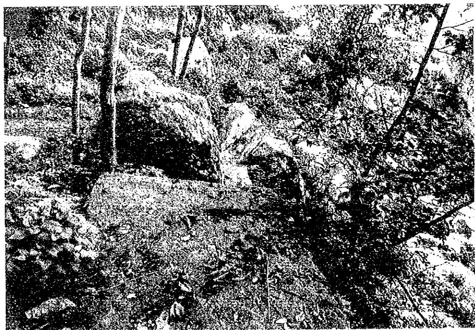
写真-35 砂防ダムは、大礫を有効に利用し、施工されている。
