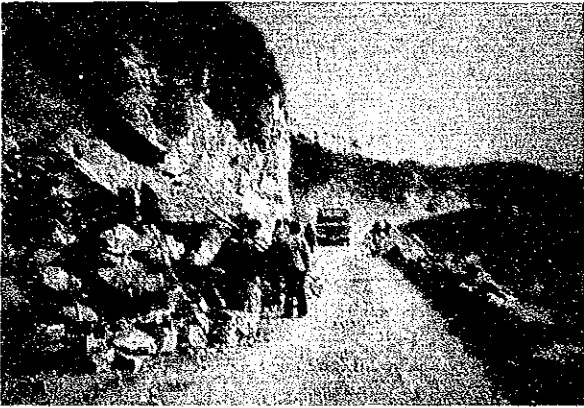
新昌付近省道の改良工事—1
