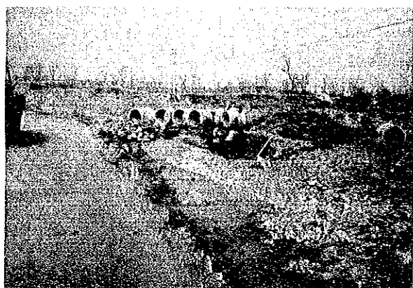
金華—建徳間の道路拡張工事
