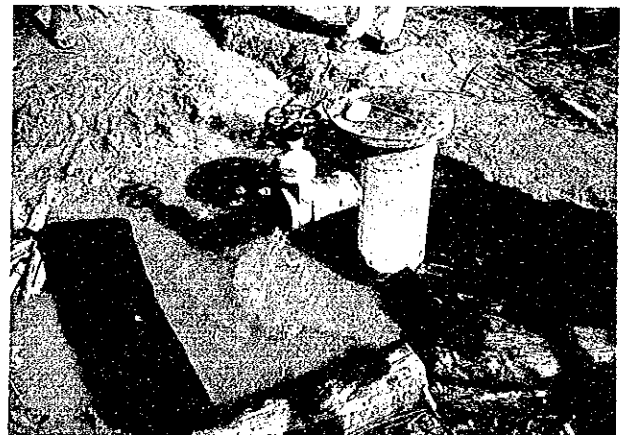
No. 9 ルンビニ県農村総合開発計画調査の際掘削された調査井戸（10"/6"）でわずかの水が自噴している
