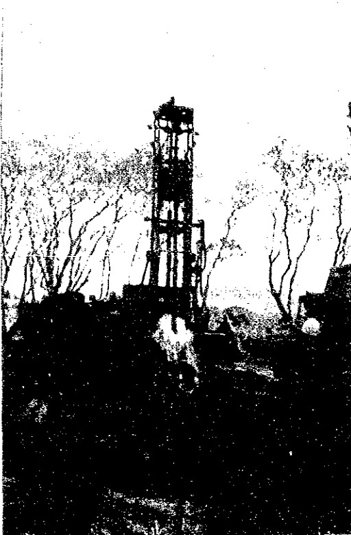
IFADプロジェクトで 作業中の日本より供与した 掘削機 (計画対象地域内)
