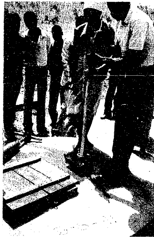
VLOM方式によるボンプの修理 (UNICEFがソマリア外で完成した 井戸：ンチシ地区)
