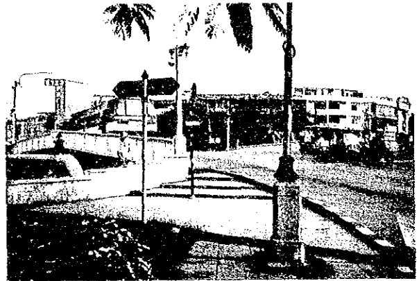
▲ 地盤沈下による橋脚の抜け上がり現象
