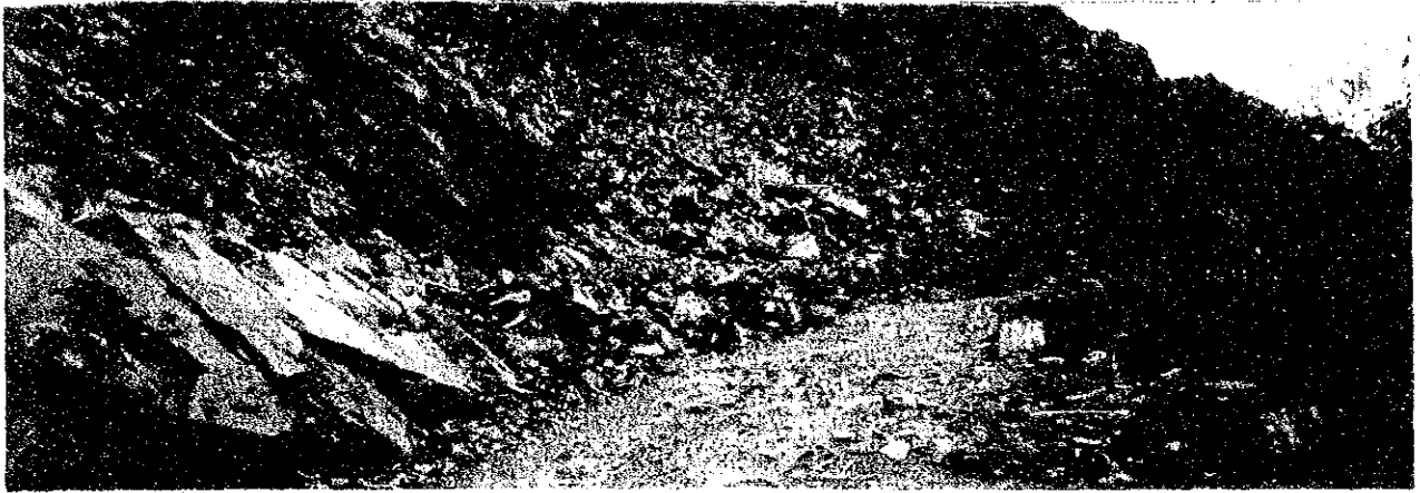
架橋地点までの途中の道路状況（崖崩れのためサイトへのアクセス不能）
