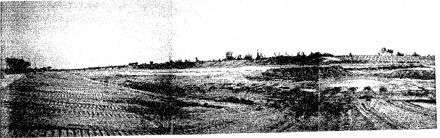
パーシグ・ポトレロ川、サンタバーバラ橋上流側の河床上昇
