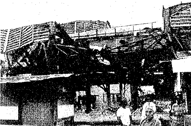
降灰後の雨による家屋倒壊
