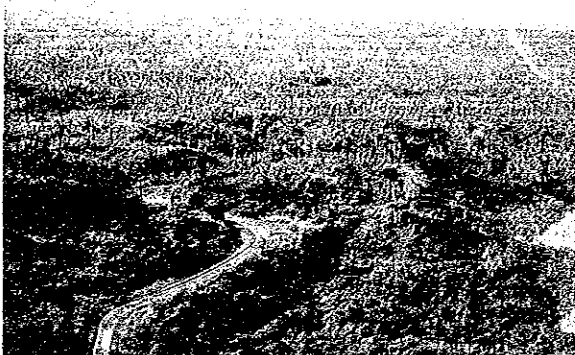
日比友好道路（国道1号）、ダエット／シボコット間
