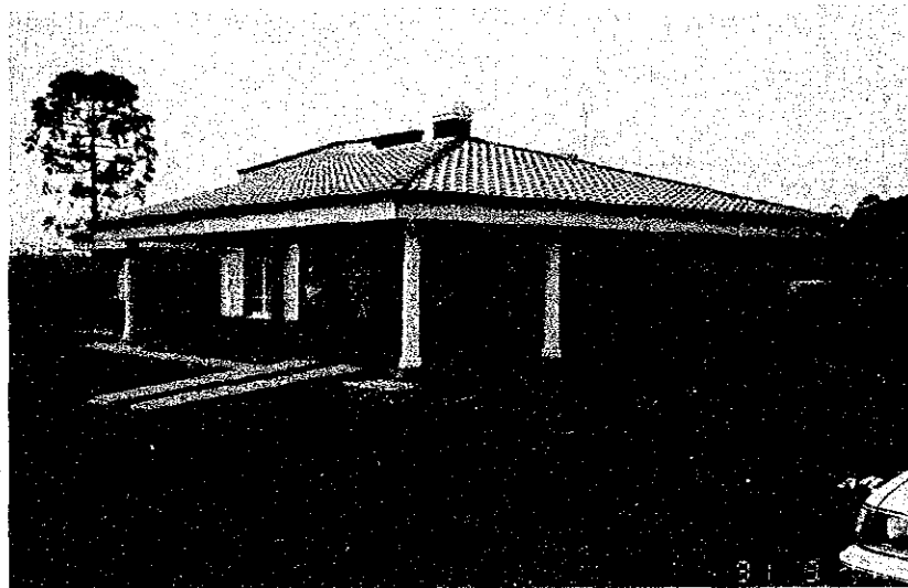
ラパス移住地内農家の新築なった住宅 (右手後方は従来の住宅)
