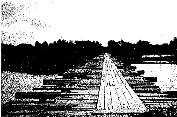
写真-4 海外貿易開発協会の融資による 250メートルの木橋（1973年建設）。
