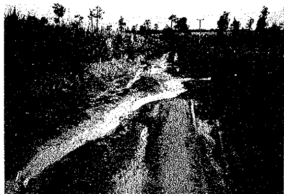
写真-3 整備が必要なラテライト道路
