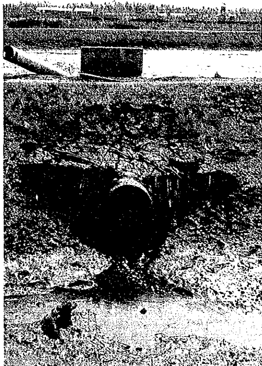
ネガラの池の出水口周辺がくずれ漏水が 問題となっている
