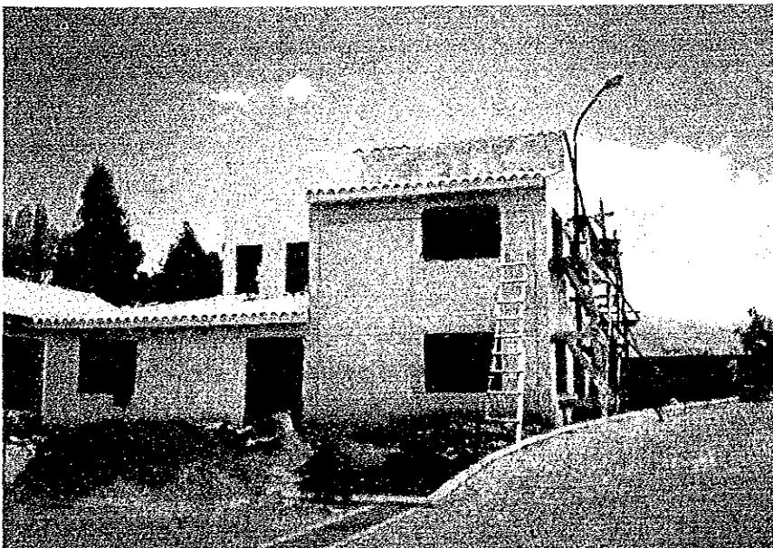
建設中の専門家用宿舎
