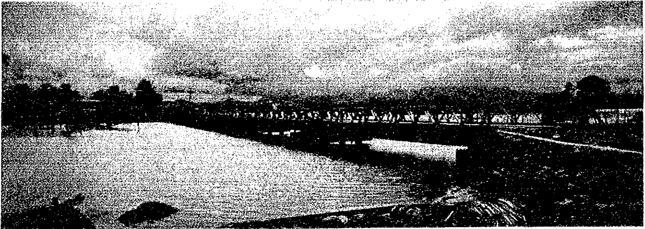
下流側より見た橋梁全景
