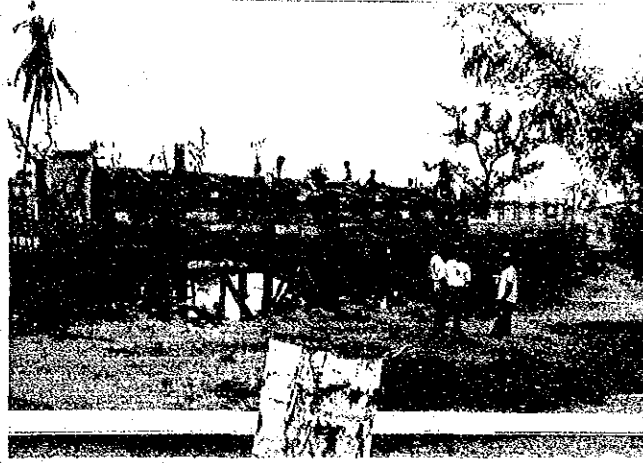
上流側より見た橋梁側景
