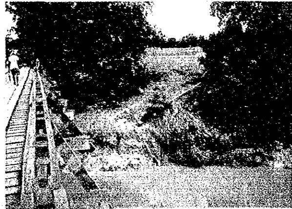
橋梁側景（上流側）
