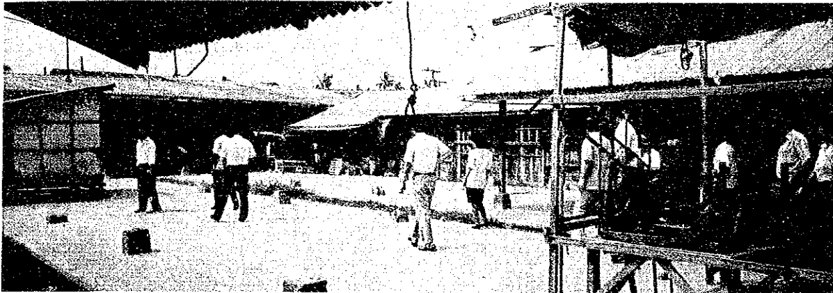
台風によって棟が壊れたダナオ市場内部
