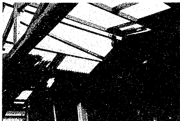
台風で飛ばされたトレド屠殺場の屋根
