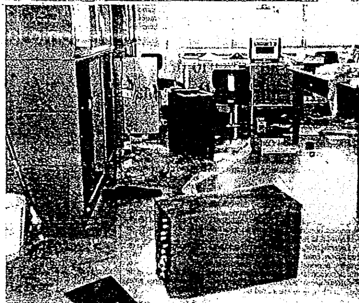
Se observa el estado en que quedó el equipo que era utilizado en el Instituto Nacional para la Formación Profesional, en el desempeño de las importantes labores que aquí se llevaron a cabo. En igual condición se encuentran las estructuras del lugar, que se espera mejoren con el apoyo del gobierno japonés.
