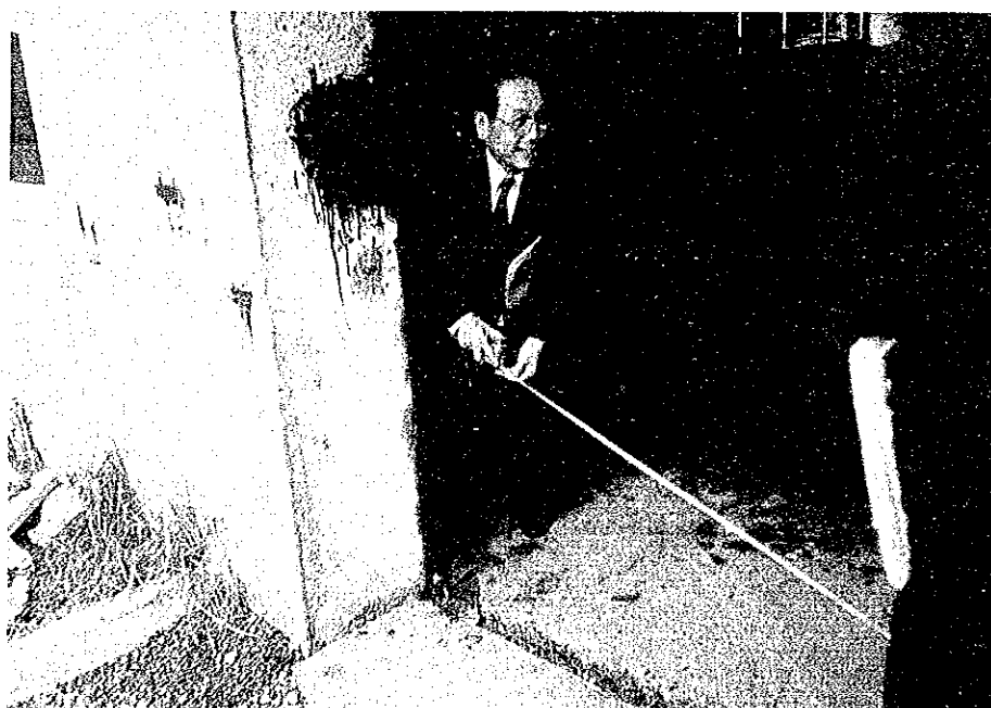
エンジンプラント据付にかかわる調査団測量風景
