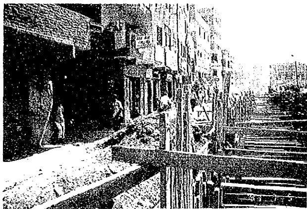
「エ」側による排水幹線、直径 1.600 mm を開削工法による埋設現場
