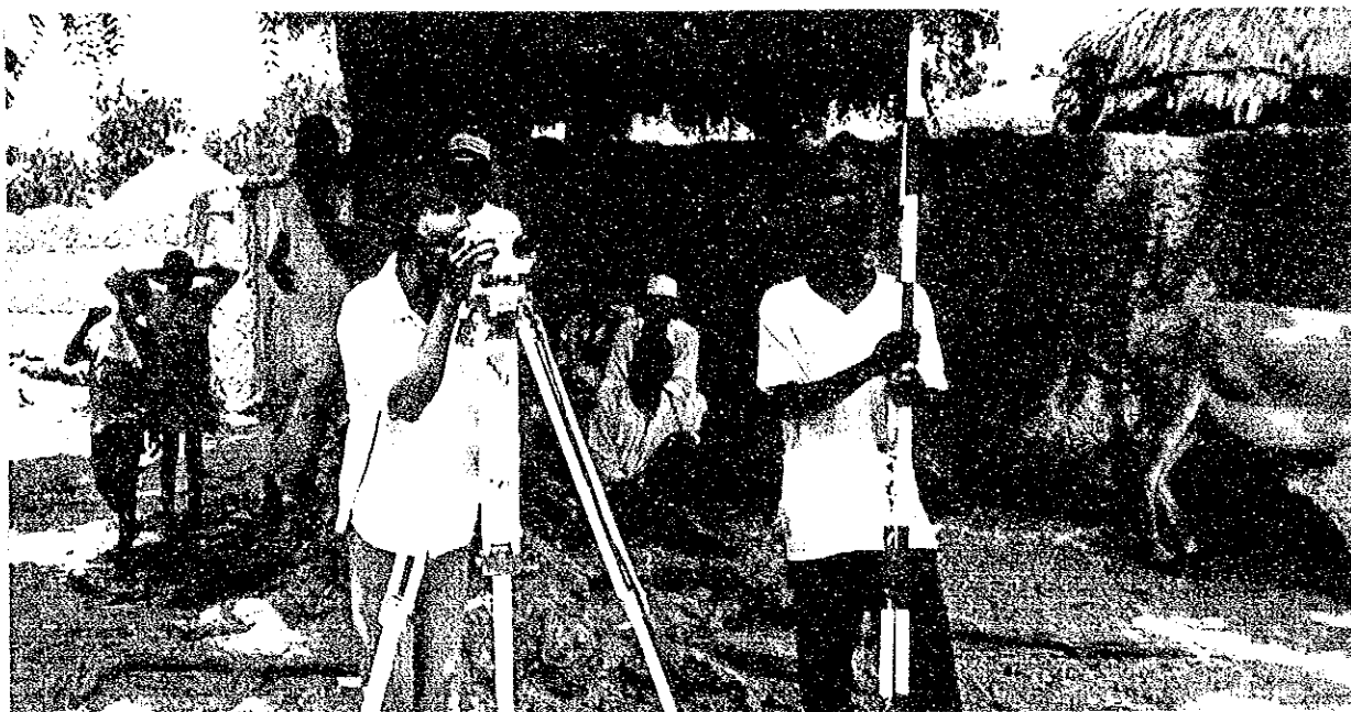
給水施設設計のための水準測量風景。ヤンプキ村。
