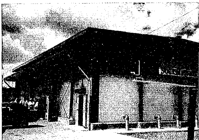
日本の水産無償により建設された冷凍冷蔵庫（アンタナナリボ市内）
