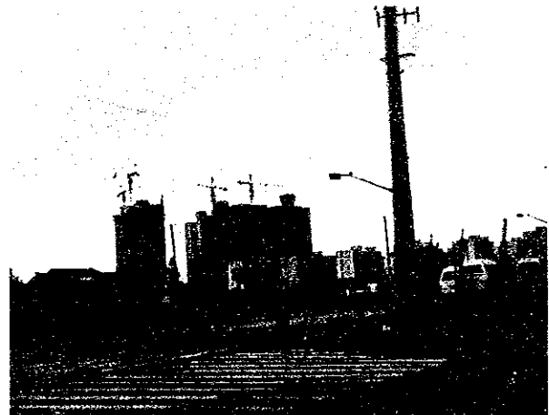
▲ 浦東新区の建設中の住宅群
