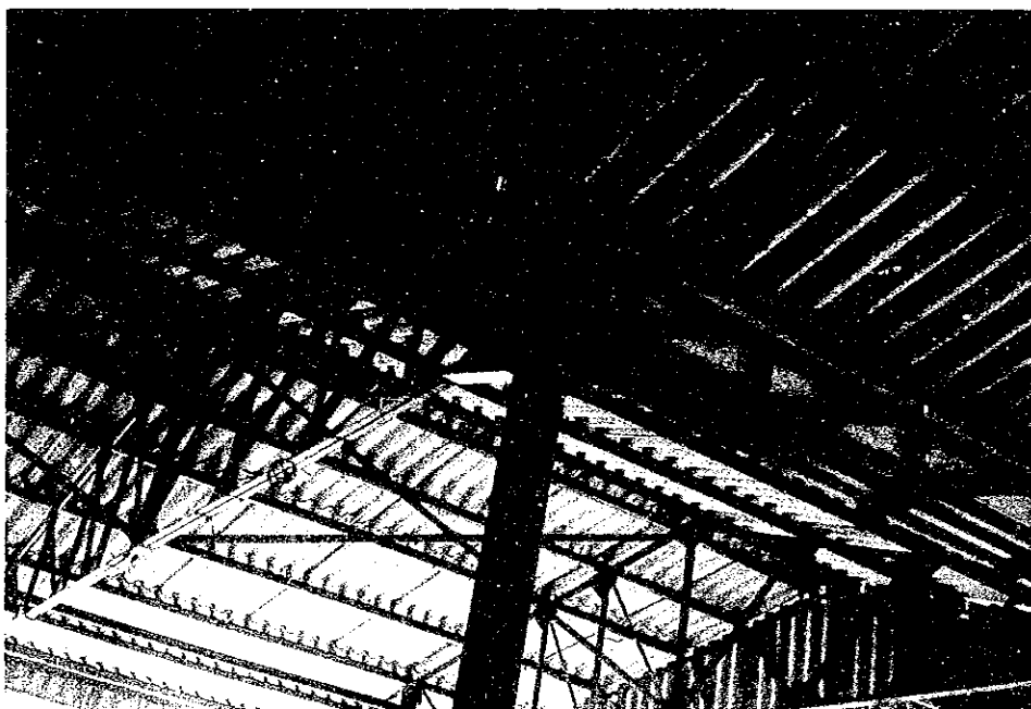
スレート式勾配屋根（ンゲラウ市場）
