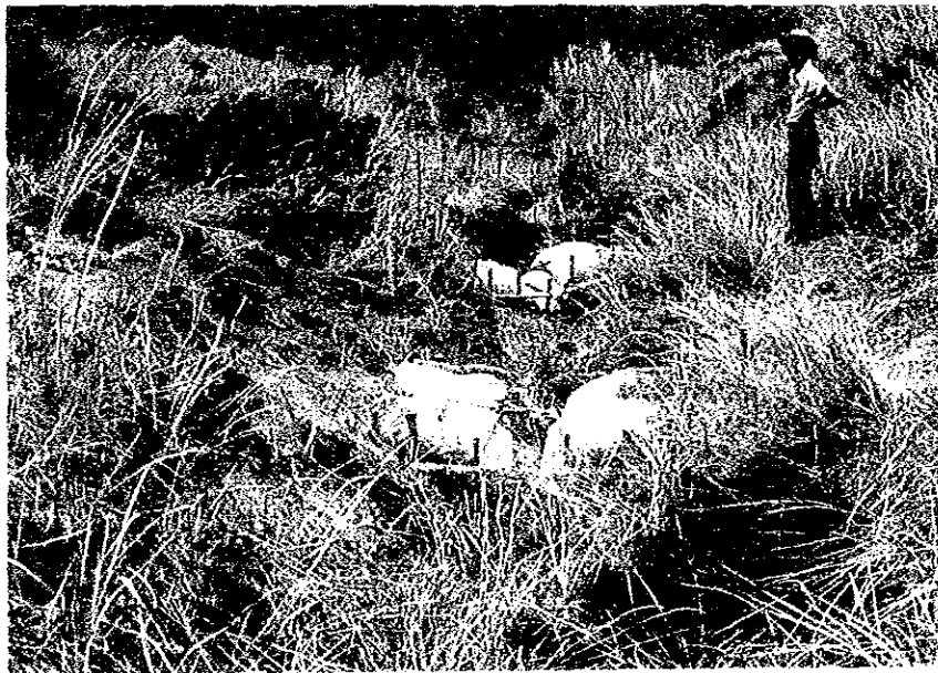
写真 (2-6) 木梓土のう積治山ダム工 (パーセル154林班)
