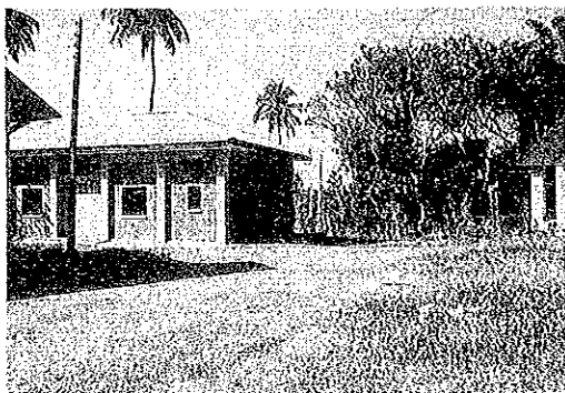
写真Ⅱ-5 ワルピタ訓練センター 日本の協力による建物
