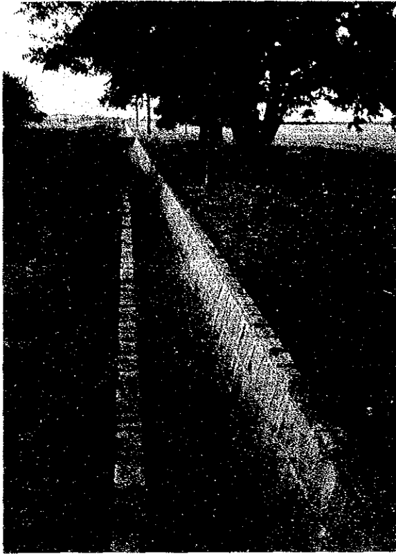
応急対策費にて設置された排水路
