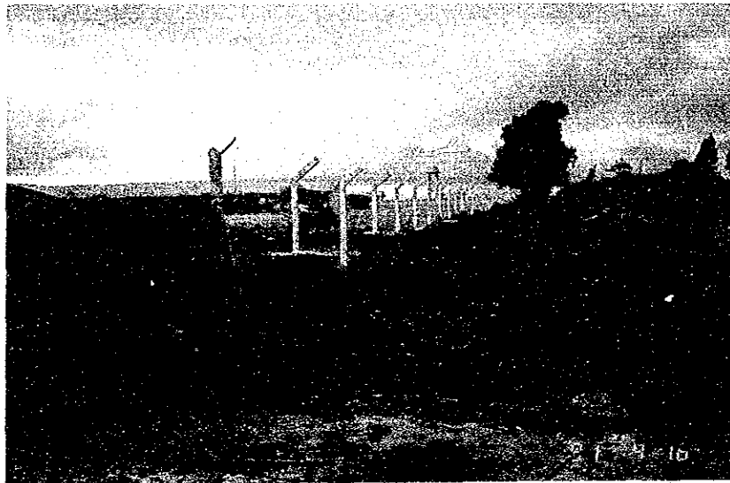
応急対策費にて 設置された金網柵
