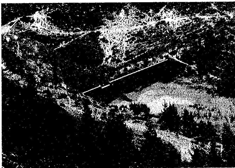
アプルコ川上流域（サウトラ村付近）砂防ダム（写真-6）
