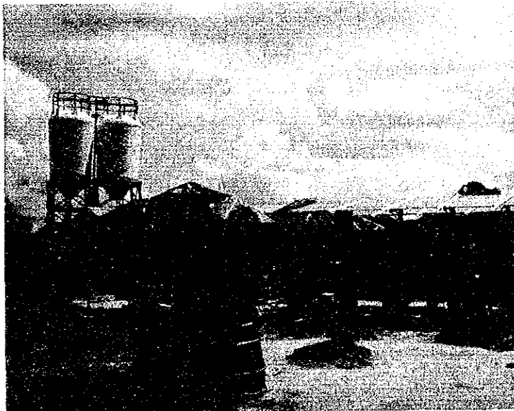
Petite adduction d'eau: petite adduction d'eau en construction dans le cadre du Projet Lagune. Village Ganbié, district ATLANTIQUE
