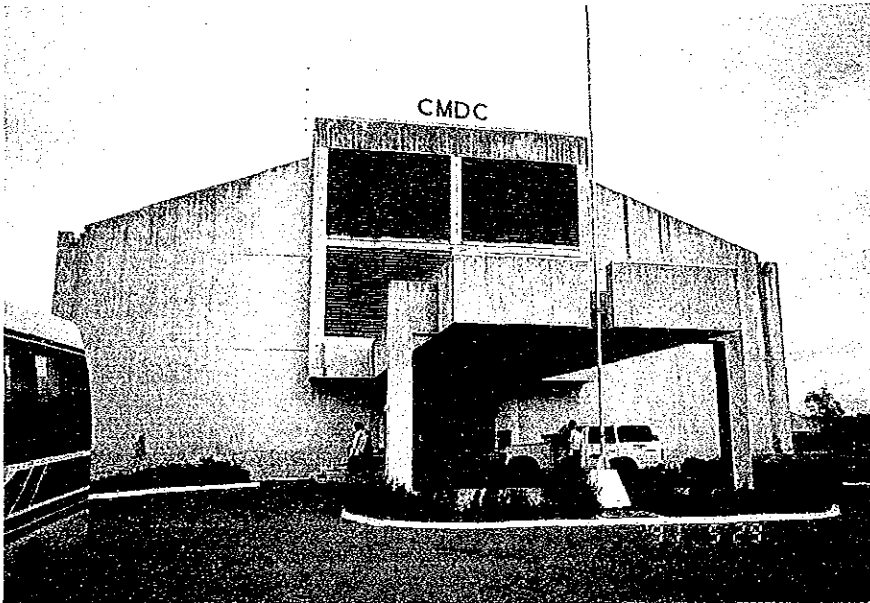
建設人材養成センターのメインビルディング
