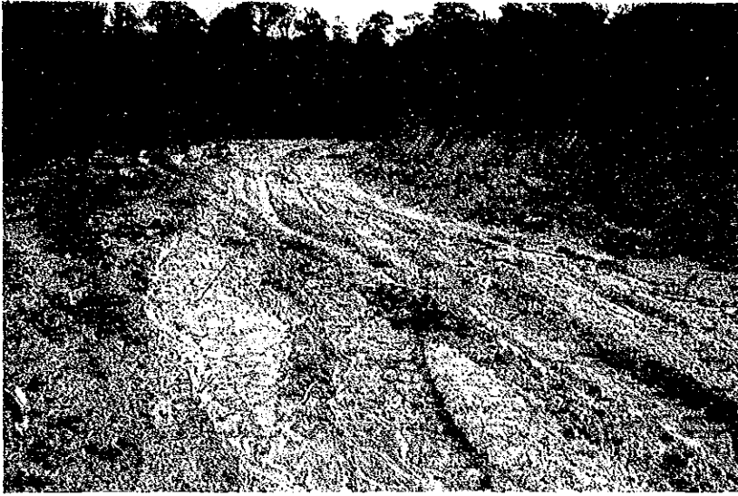
写真-7 豪雨で路体が泥ねい化した林道路面
