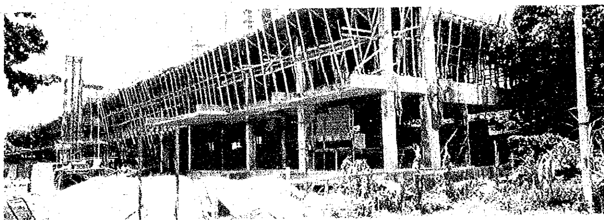
新校舍建設現場
