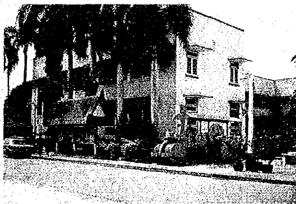
④電気工学校舎
