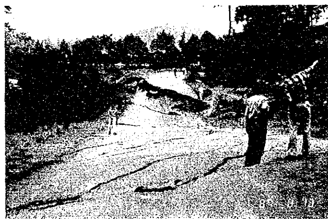
西ジャワのPuncalc地滑りはバンドンとジャカルタを結ぶ国道を横切る形で発生した。旧国道は地滑りによって破壊され、新国道は旧国道の上部に新しく建設された。
