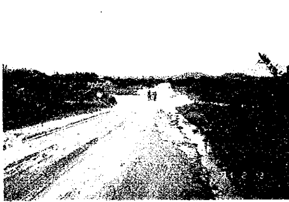
一級国道でも路床がないため増水するとすぐ冠水する
