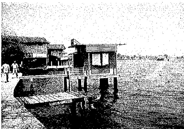
メモリアル橋水位観測所 C4 WATER LEVEL GAUGE (MEMORIAL BRIDGE)
