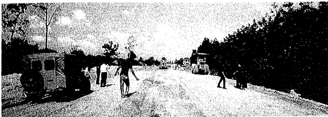
工事状況全景。路盤の敷き均し及び締め固め
