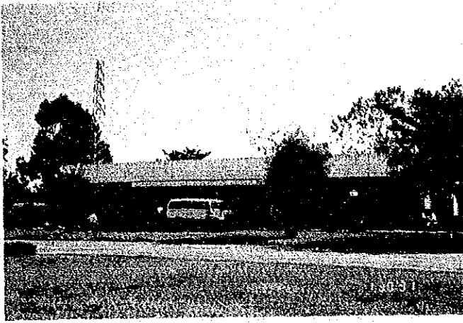
スラタニ道路建設センター全景
