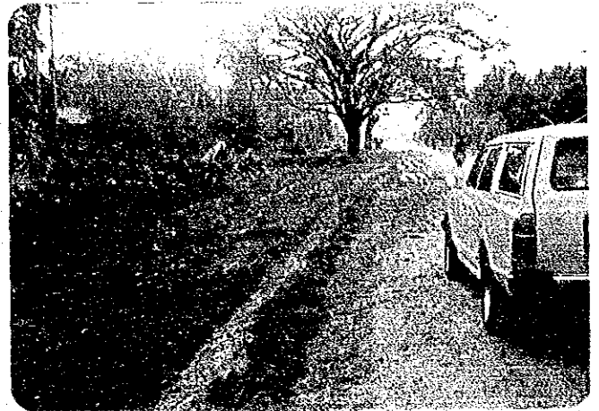
旧道路際に街路樹は撤去される。 旧道路際の両サイドと道路との高低差は無く雨季に冠水する。
