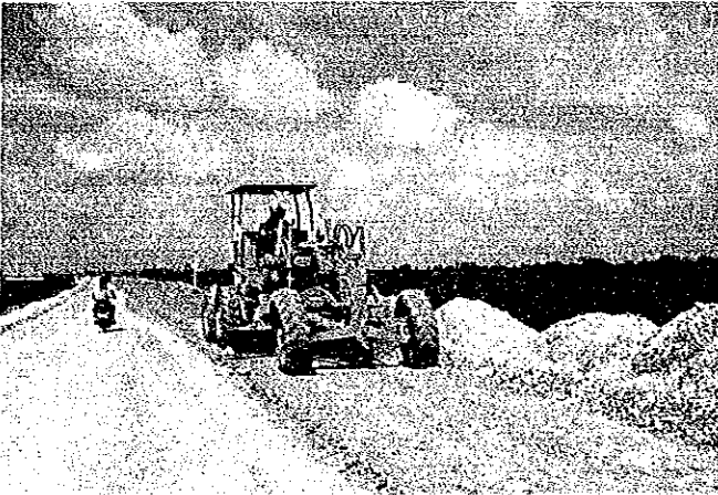
モーターグレーダーによる路盤材の敷均作業状況
