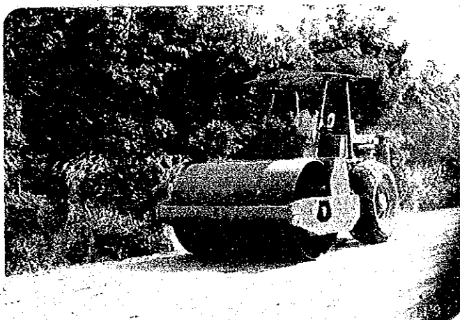
タンデムローラによる路盤の締め固め
