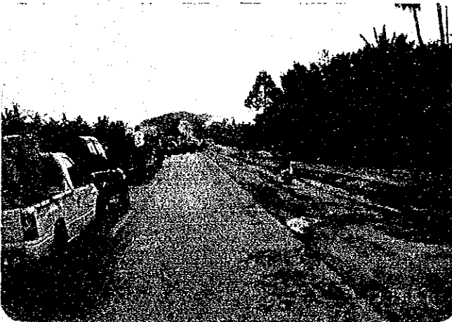
盛土用の材料が運び込まれるとこの様に 交通は遮断される。
