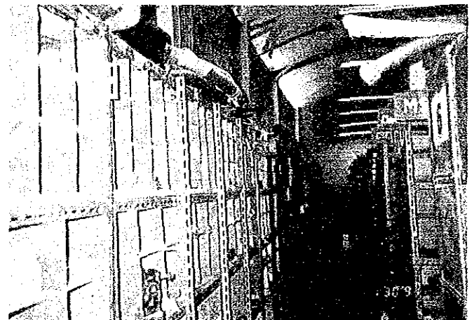
スベアパーツ保管状況。
