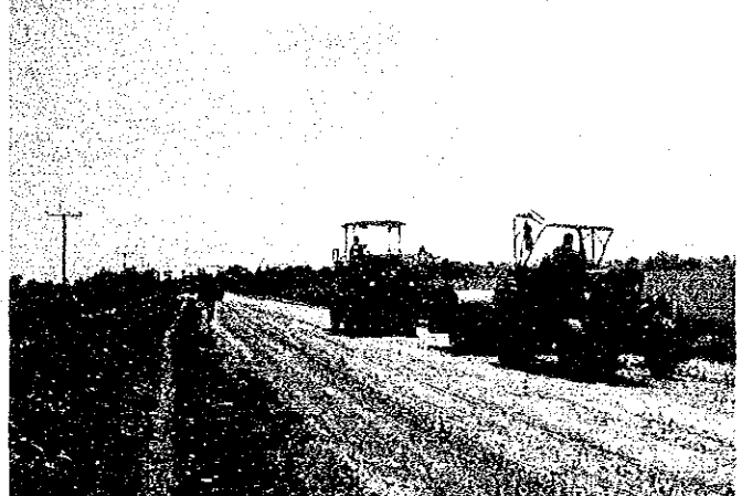
タイロラー及び披けん引式振動ローラーによる作業状況
