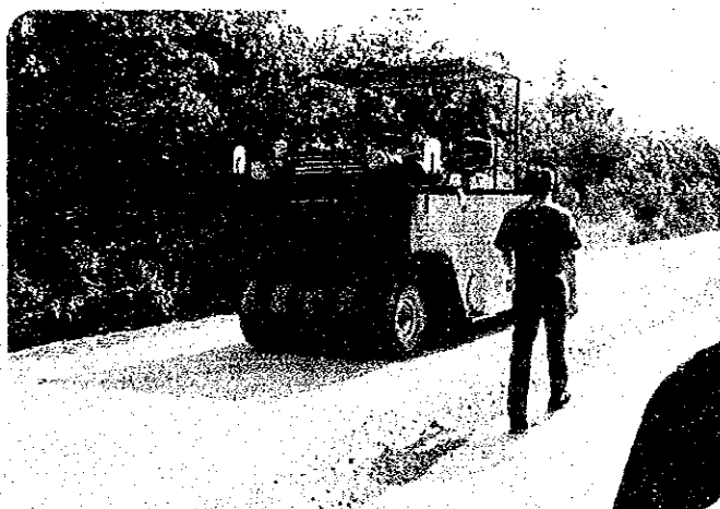
タイヤによる上部路盤の締め固め
