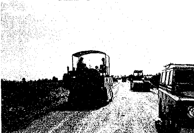
タイロラーによる作業状況
