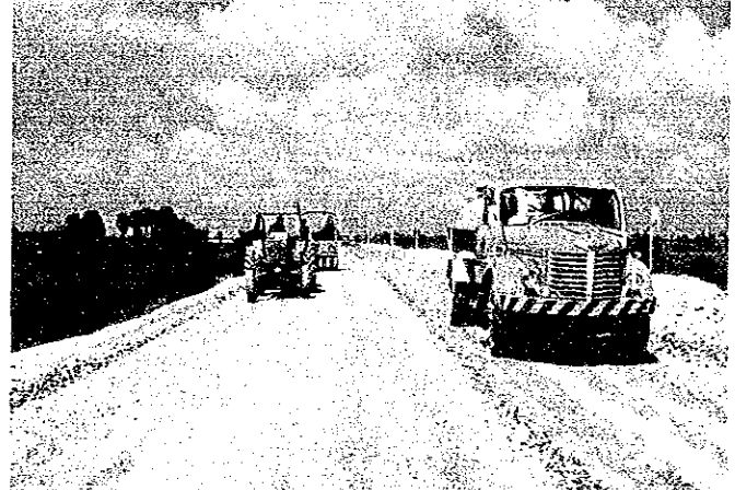
散水車による作業状況
