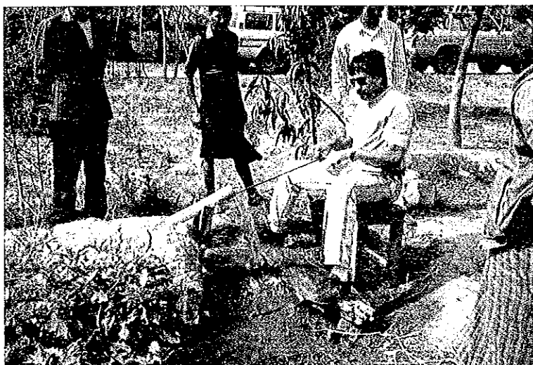
ネパールガンジ周辺の農家の庭先でみた手動ポンプ吸い上げ方式の浅井戸（20m以下）
