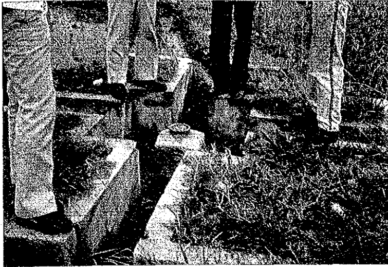
Ahirauli 深井戸からのパイプライン配水システムの末端分水工
