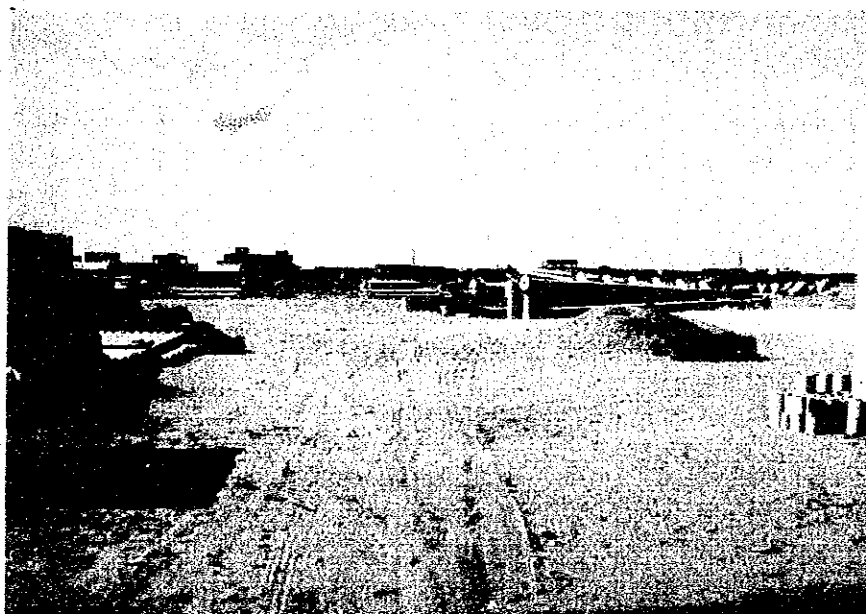
NUWC資材置場 (カルツーム地区 南部配水ポンプ場に隣接)
