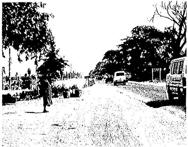
▲ 国道4号線。ベチャブリからホアヒンにかけて拡張工事が行われている
