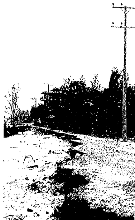
▲ 海岸侵食で破壊されたホアヒンの道路
