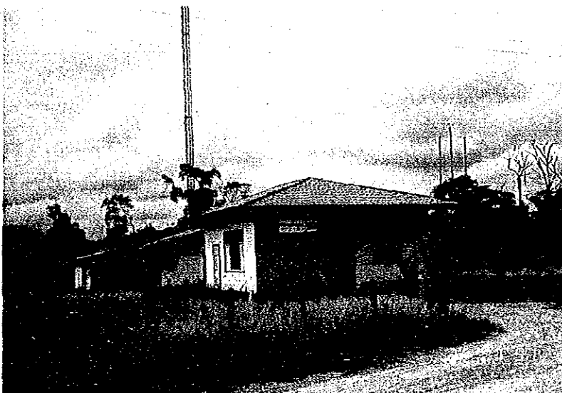
TELEPARA 第二トメアス移住地電話局 (イピランガ地区)
