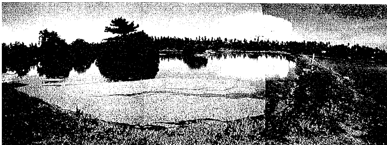
▲ BTDC汚水処理施設 (左側：第1池、右側：第3池、奥：第2池)
