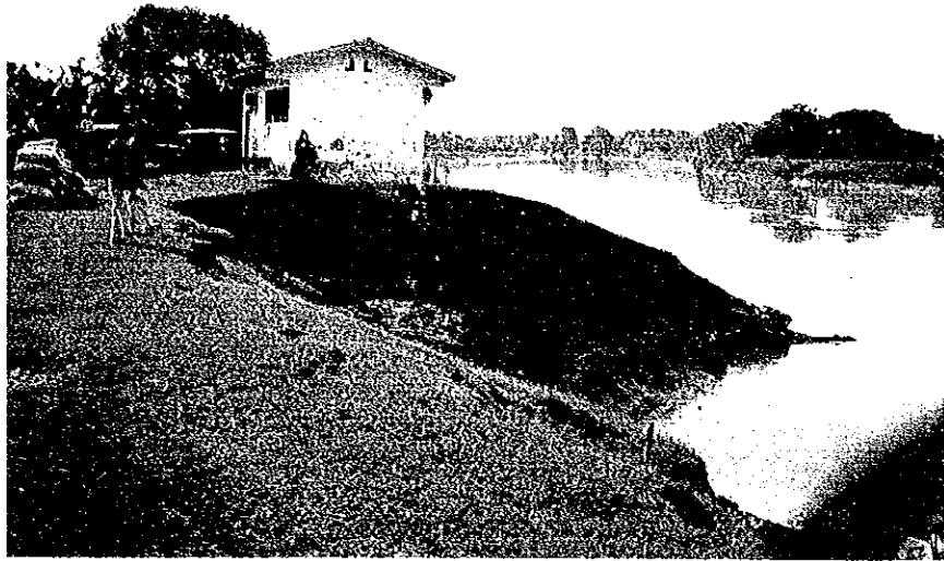
ポンプ場の下流側の河岸の浸食の状況 SARIREJO PUMPING STATION (No. 16)
